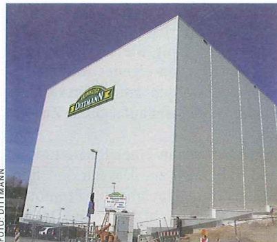
FOTO: DITTMANN Neu gebaut: Hochregallager am Standort Taunusstein.
